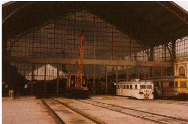
Foto 2: Estado previo a la restauración.
